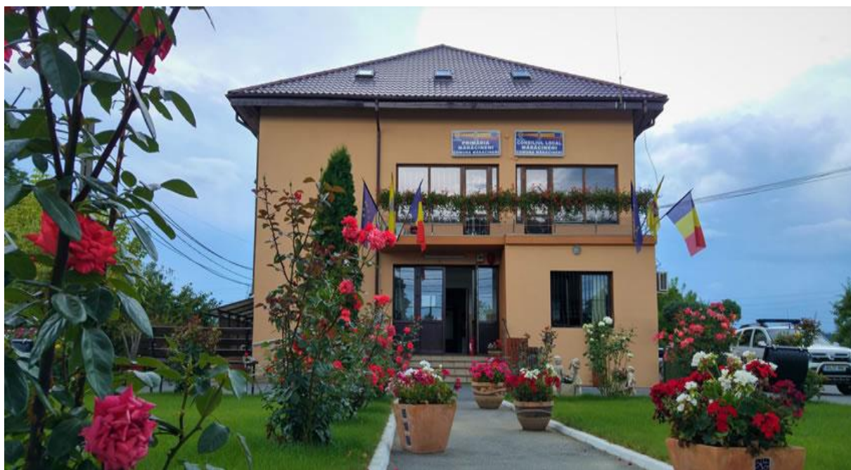
Sediul Primăriei Mărăcineni
